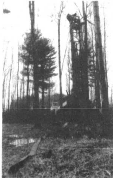
À la recherche d'eau potable, Saint-Jean-Baptiste a mandaté une firme pour faire des forages à différents endroits le long du rang des Étangs. En mars, on trouvait effectivement des sources d'eau.
