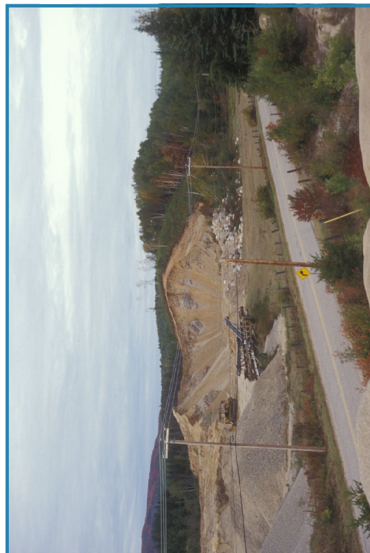
Photo 31 : Esker. Faces de 8 à 12 m de hauteur composées de galets et de cailloux arrondis dans une matrice sableuse à sablo-silteuse, compacte et grossièrement stratifiée. Présence de lits silto-argileux (rythmites). La granulométrie varie rapidement (source 27, site 305, 31J11).
