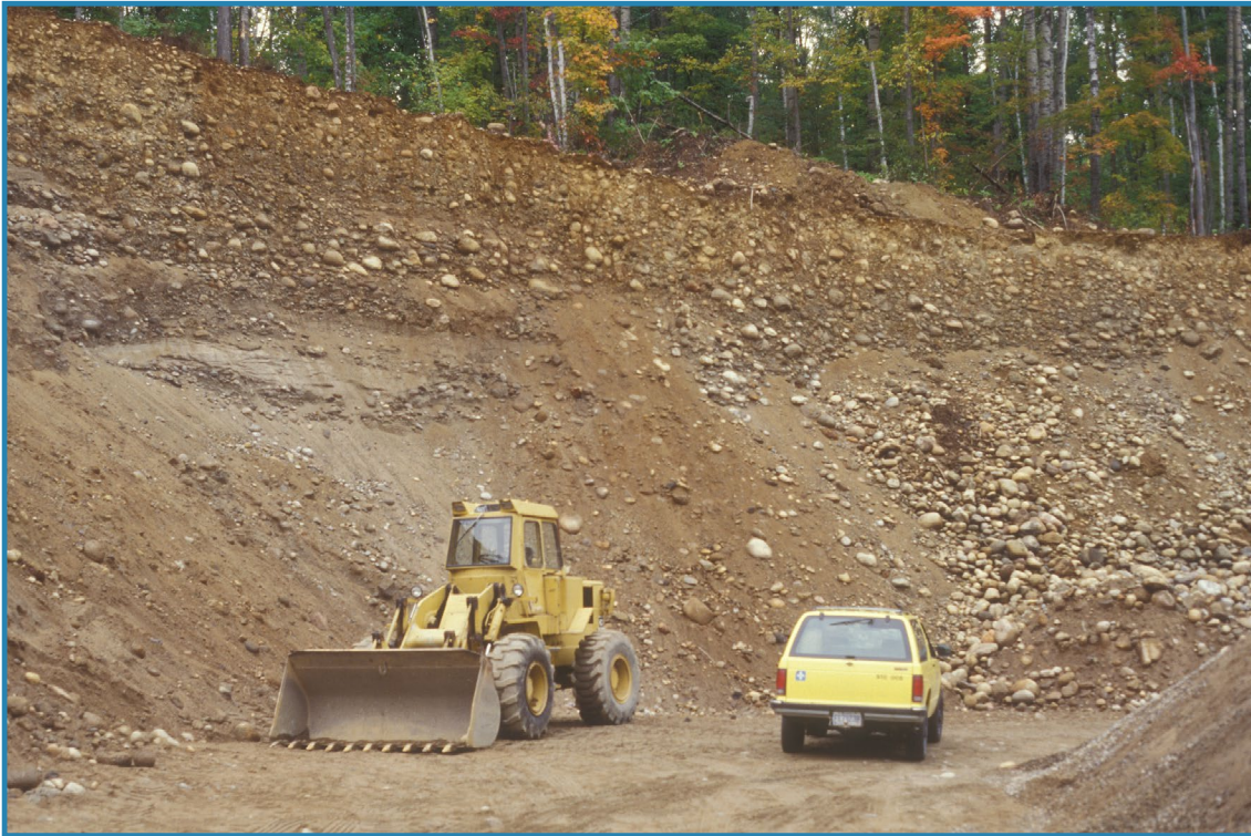
Photo 7 : Face de 8 à 10 m de hauteur composée de galets et de cailloux arrondis et jointifs avec quelques lits sableux (source 9, site 49 en 1995, 31J05).
