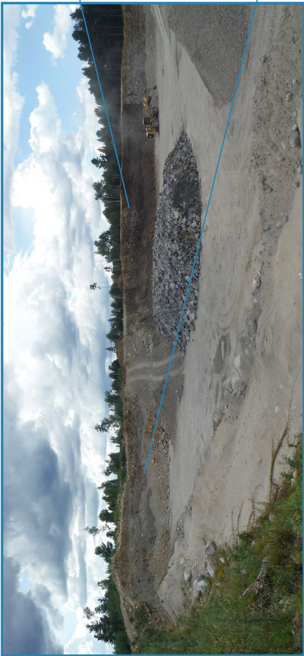
Photo 51 : Importante exploitation commerciale aussi exploitée en carrière. Faces de 6 à 8 m de hauteur composées de galets et de cailloux arrondis, jointifs ou dans une matrice sableuse selon l'endroit. Présence de lits sableux (source 41, site 380, 31J07).
