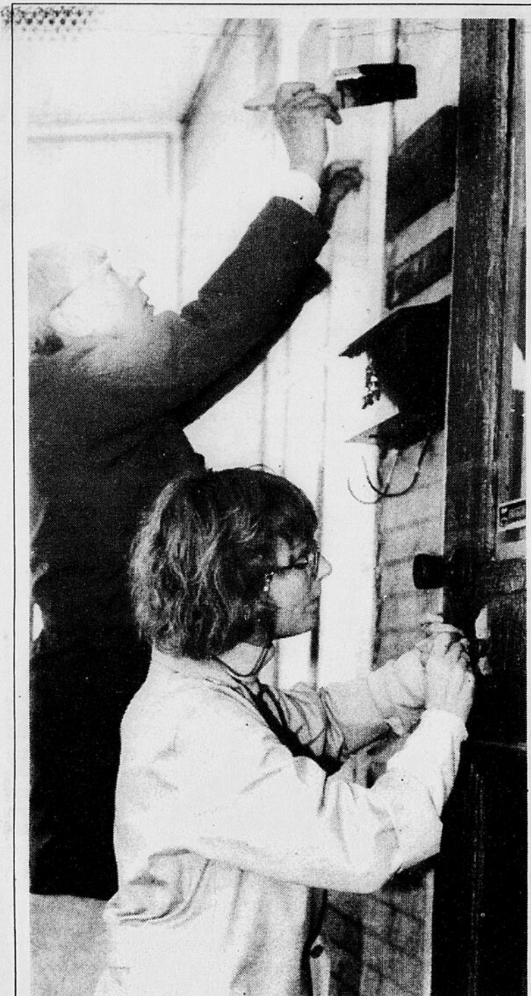
TRAVAUX - Les travaux de restauration se poursuivent à la maison du peintre Arthur Villeneuve, de la rue Taché, à Chicoutimi. Le déménagement est prévu pour la mi-novembre. (Photo Rocket Lavoie)
