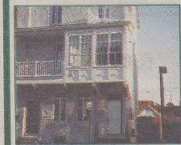
Ch3517 - 1 logement de 6 1/2 pièces + 2 locaux commerciaux, tous loués, rénovation 1991 et 1999, terrasse à palier en bois traité en arrière. Inf. : Michel Lanoix
