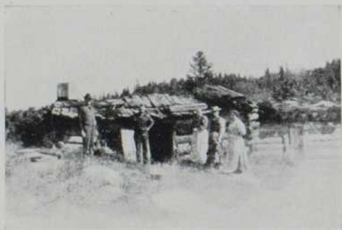
Le premier chantier construit par M. S. Alix, en 1885.
