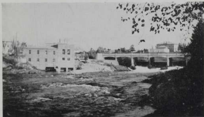
L'usine électrique et le Rapide de l'Original
