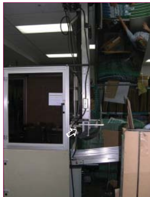
Vue en profondeur de la section qui achemine les retailles à l'aide des courroies.
