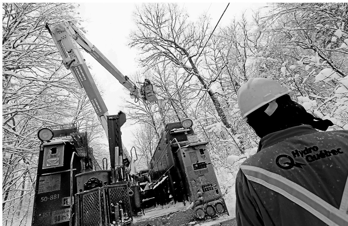
Ce sont les monteurs de ligne qui ont obtenu la part du lion, avec 28 millions $ des 132 millions $ versés en heures supplémentaires par Hydro-Québec. — SIMON SÉGUIN-BERTRAND, ARCHIVES LE DROIT
