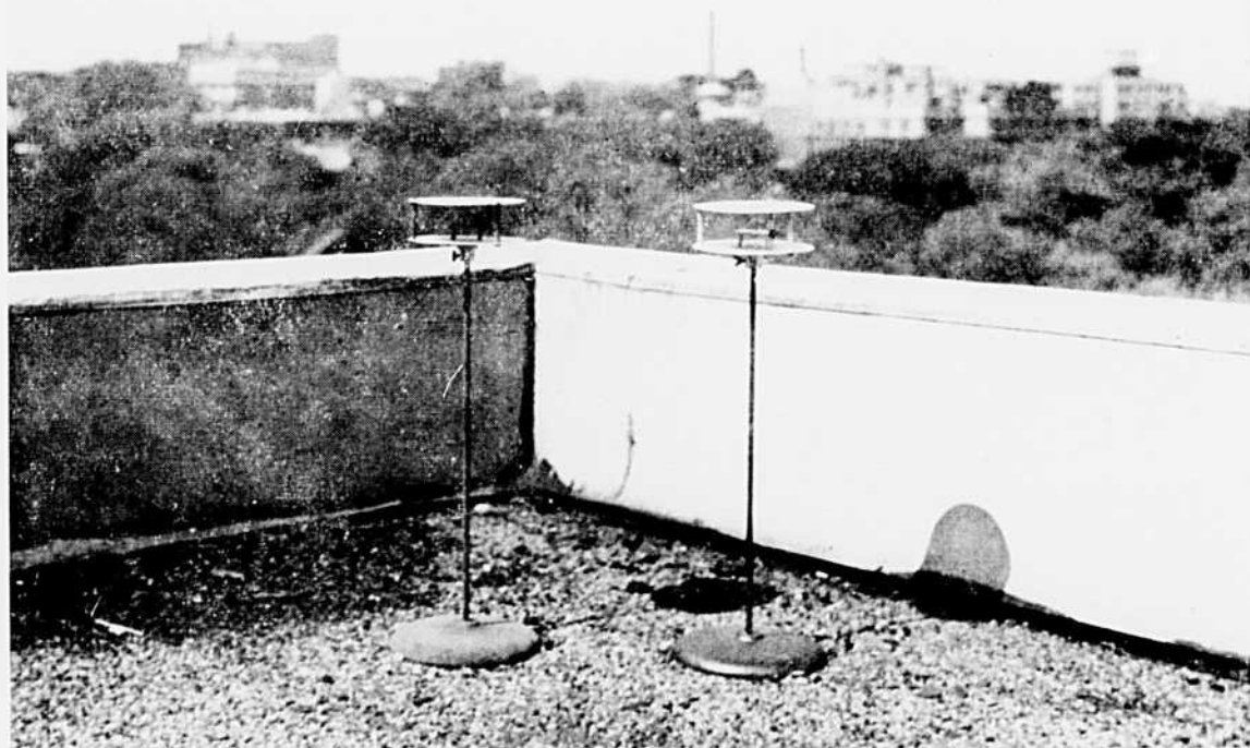
APPAREILS DURHAM SUR TOITURE DURHAM DEVICE ON ROOF
