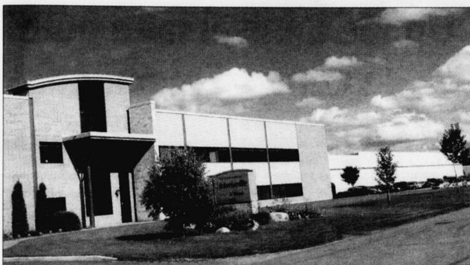
Le nouveau centre de distribution se construira derrière Cercueils Vic Royal, l'agrandissant de 40 000 pieds carrés.
