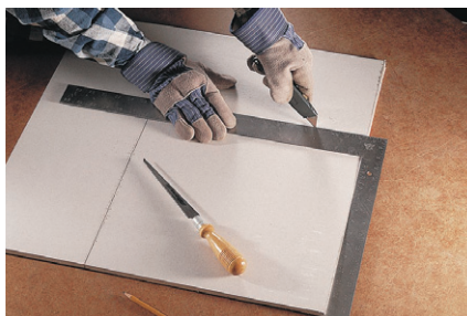
B. Découpez la pièce dans un morceau de plaque de plâtre, en utilisant une équerre de charpentier et un couteau universel.
