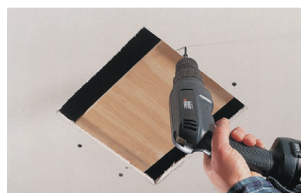
F. Fixez au moyen de vis le support installé dans l'ouverture.
