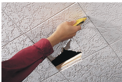
G. Découpez le carreau endommagé en morceaux, à l'aide d'un couteau universel.
