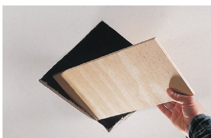
E. Utilisez un morceau de contreplaqué comme support de la pièce.
