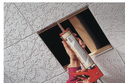
I. Appliquez de l'adhésif de construction et pressez le nouveau carreau en place.
