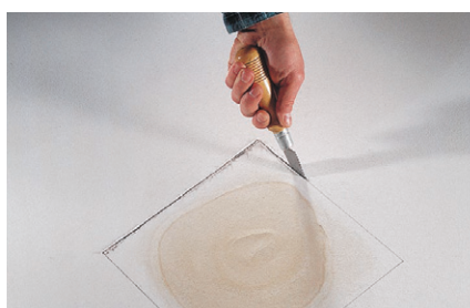
D. Découpez l'endroit abîmé du plafond avec une scie à plaque de plâtre.
