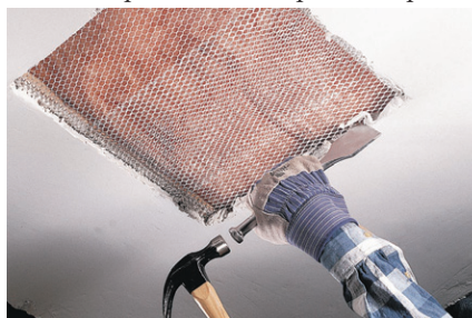
A. Découpez soigneusement une ouverture en entaillant la surface avec un couteau universel et en ôtant le plâtre avec un ciseau.
