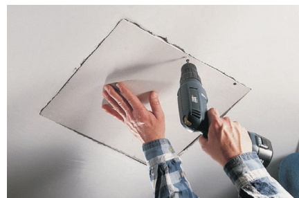
C. Fixez la pièce en place avec des vis à plaque de plâtre. Espacez les vis de 4 à 6 po.
