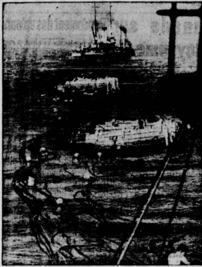
Un vaste réseau de câbles et de chaînes s'étend du bateau de sauvetage "Falcon" (avant-plan) aux pontons rattachés au sous-marin "Squalus", qui a déjà été soulevé de 80 pieds de son lit de boue, au large de Portsmouth, N.H. A l'arrière-plan, le remorqueur "Wandank".
