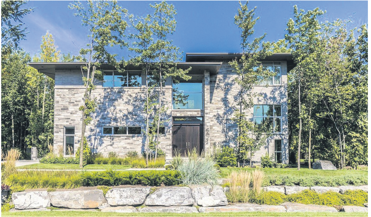
L'avancée de 4 pi du toit, lequel n'est pas plat malgré les apparences, procure de l'ombre en été et laisse entrer la lumière en hiver. Chacune des portes d'entrée mesure 44 po de largeur!
