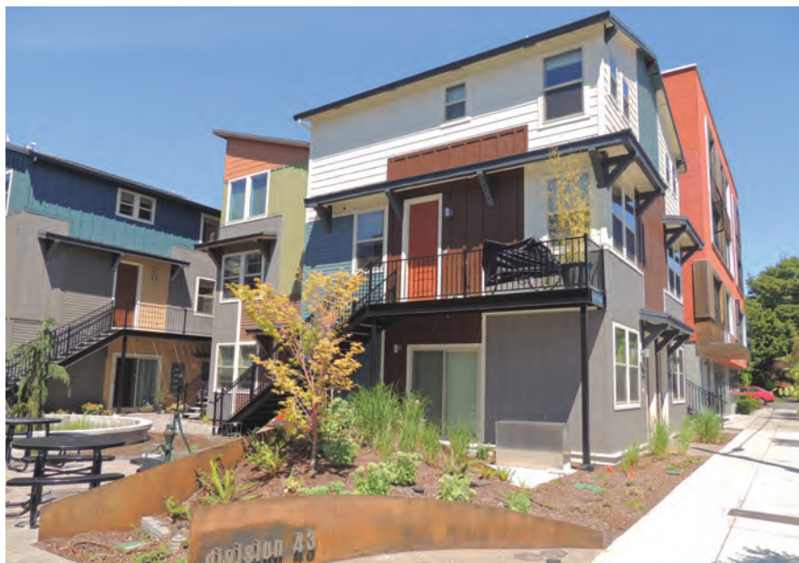
Division 43, à Portland (Oregon), propose 29 logements dans 11 bâtiments sur une parcelle qui n'en comptait auparavant que deux.
