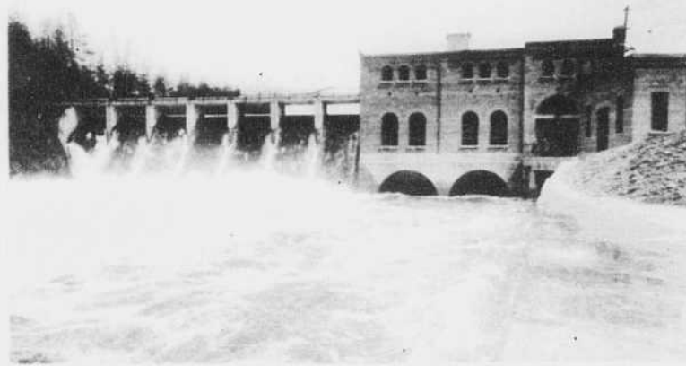
Barrage et centrale de Rock Forest, construits en 1911. Le Sherbrooke Board of Trade fut un partisan convaincu du développement hydroélectrique à Sherbrooke.
