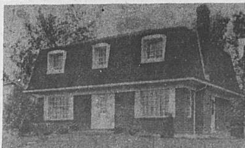
4 — BOUCHERVILLE — Belle résidence située face à un parc de verdure. 8 pièces, "custom-built". Chauffage électrique. Faut voir. Thérèse Chartrand 651-1000 - 256-6724.
