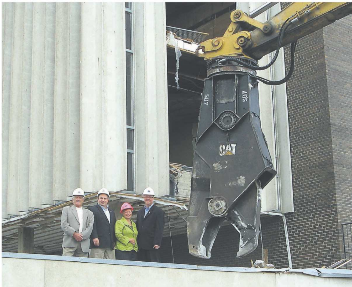
Les ex-maires de la Ville d'Asbestos, Roch Fréchette, Jean-Philippe Bachand et Louise Moisan-Coulombe étaient présents en compagnie de l'actuel maire, Hugues Grimard, lors du début des travaux de démolition de l'ancien hôtel de ville.
