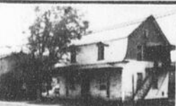
1694 St-Edouard. Eligible pour subvention de rénovation
