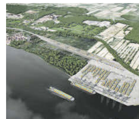
Les travaux au Port de Montréal à Contrecoeur devraient débuter à l'automne 2021. Photo gracieuseté/Ville de Contrecoeur
