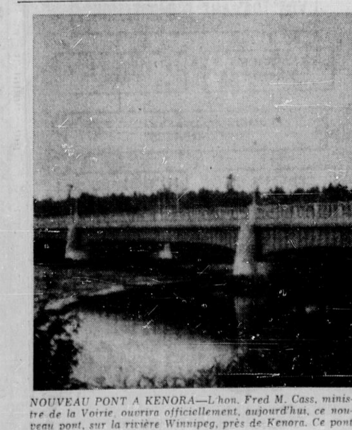
NOUVEAU PONT A KENORA —L'hon. Fred M. Cass, ministre de la Voirie, ouvrira officiellement, aujourd'hui, ce nouveau pont, sur la rivière Winnipeg, près de Kenora. Ce pont
