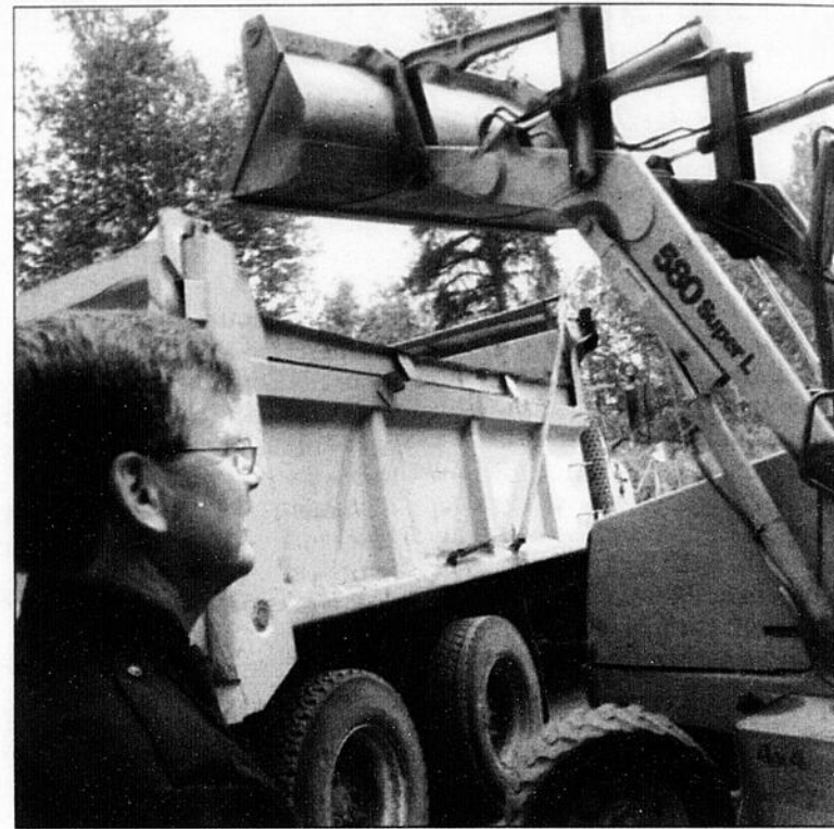
CHARGEMENT - Alcan a fourni l'équipement lourd nécessaire pour faire les travaux d'excavation et charger les plaquettes de cuivre dans les camions. Ici, le policier Bruno Cormier surveille les opérations.
