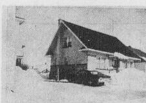
Résidence 1 étage 1/2, Rue Savard Alma. Très bonne construction. Près des écoles, églises etc.
