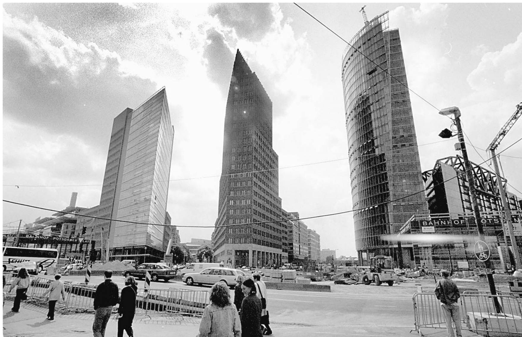
Sur Potsdamer Platz, des nouveaux sièges sociaux aux angles acérés : à gauche, les deux édifices DaimlerChrysler et à droite une partie du centre Sony.
