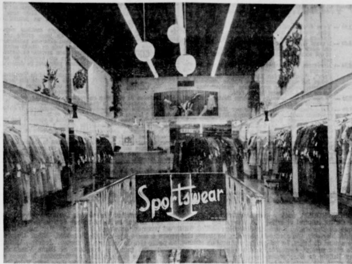
L'intérieur du magasin Rayfels, au premier plancher.
