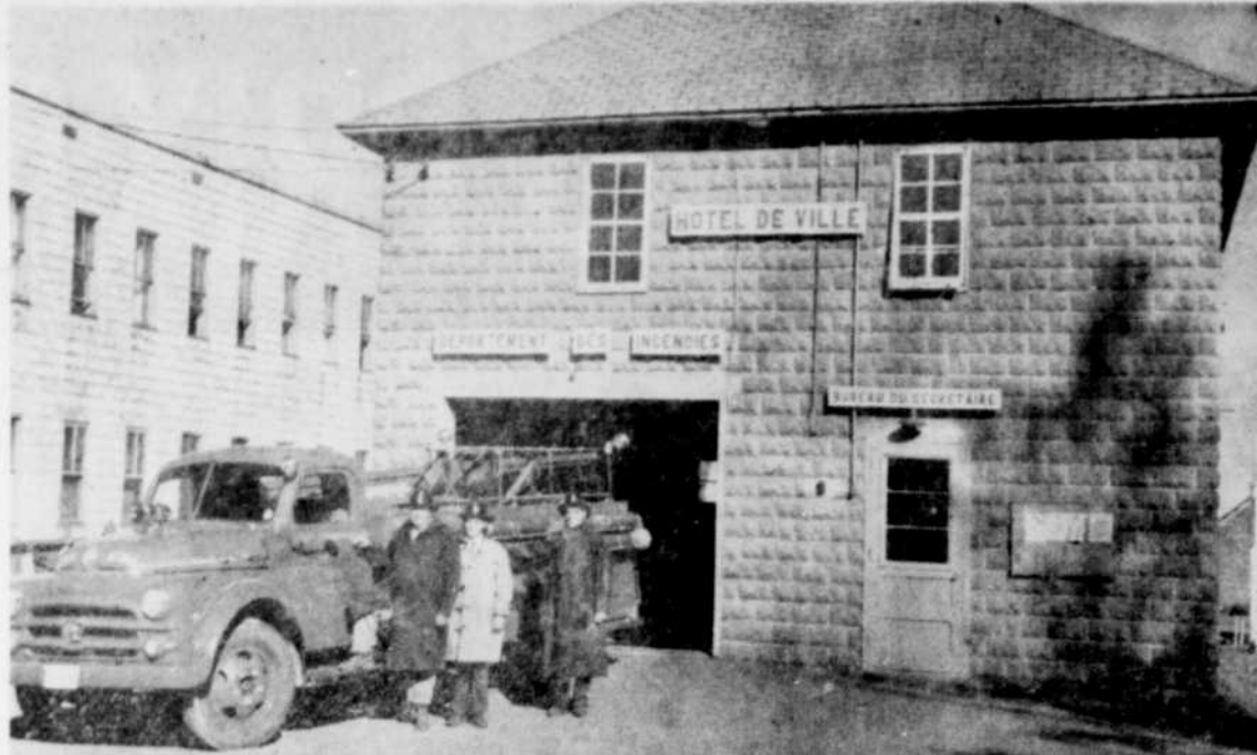
Hôtel de ville. — Le petit hôtel de ville de Weedon, en plus de la salle du conseil, renferme le bureau du secrétaire ainsi que le service des incendies. On peut voir, sur cette photo, le chef Donat Fontaine et deux de ses hommes photographiés près du camion à incendies. (Photo La Tribune, par Royal Roy)
