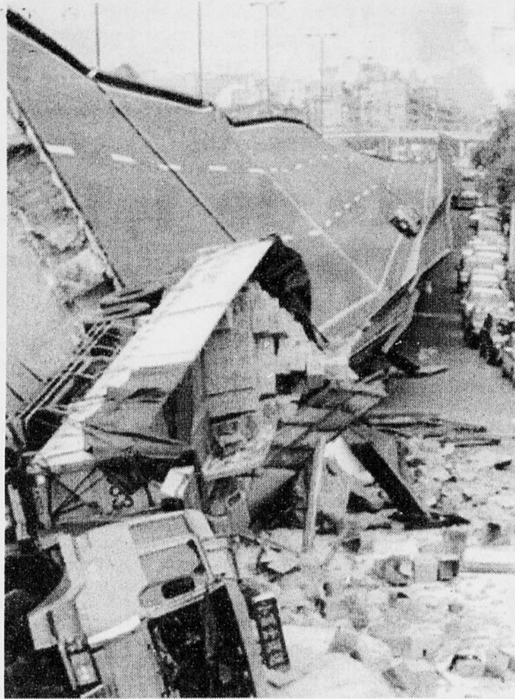
DESTRUCTION - La voie express Hanshin s'est effondrée en cinq endroits, notamment sur une section de 500 mètres; 12 conducteurs ont été tués dans la chute de leur voiture. (Photo PC)
