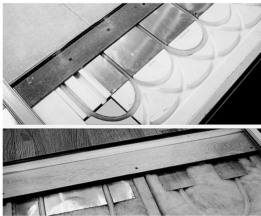
Les tuyaux du chauffage radiant hydronique peuvent être placés au-dessus ou sous le contreplaqué, selon les conditions du chantier.
