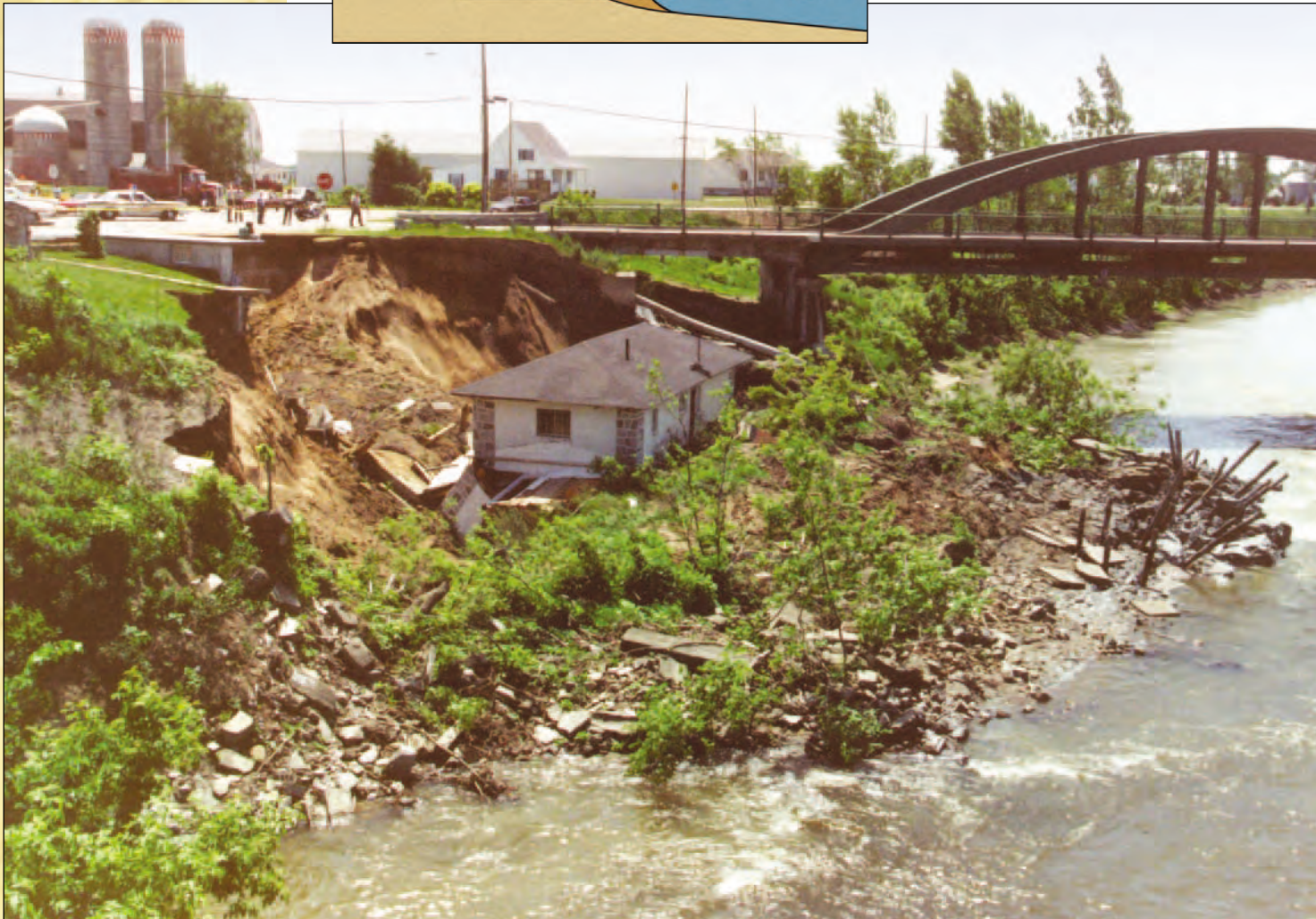
Figure 5 : Croquis et photo d'un glissement rotationnel
