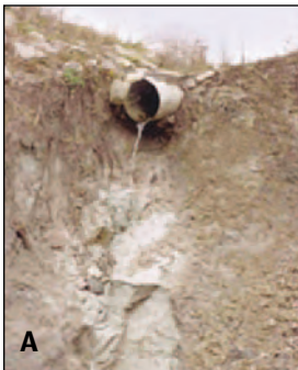
Figure 16 : Concentration d'eau (A : ravinement, B : érosion verticale)
