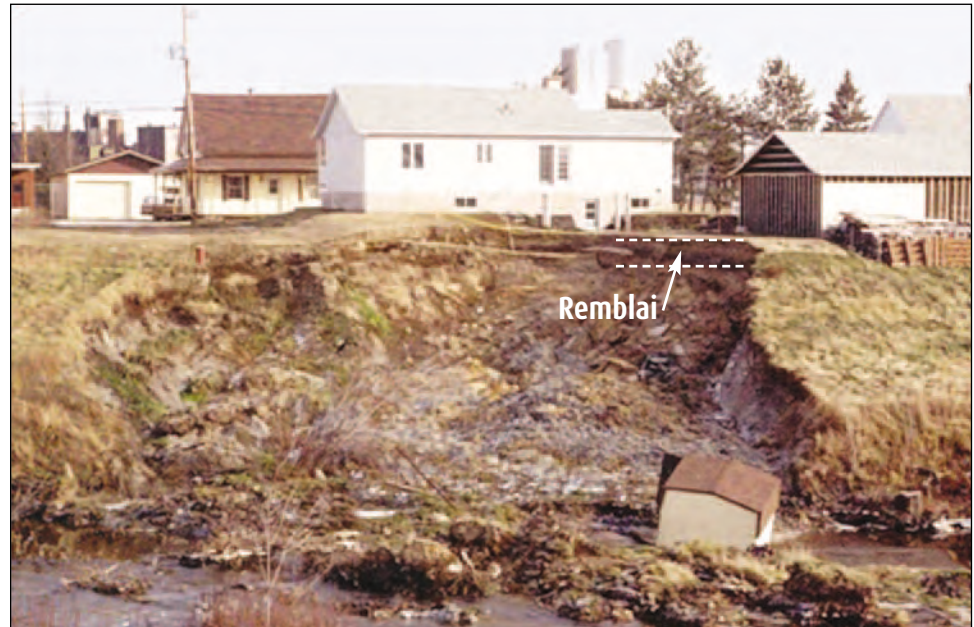
Figure 13 : Remblai mineur en sommet de talus
