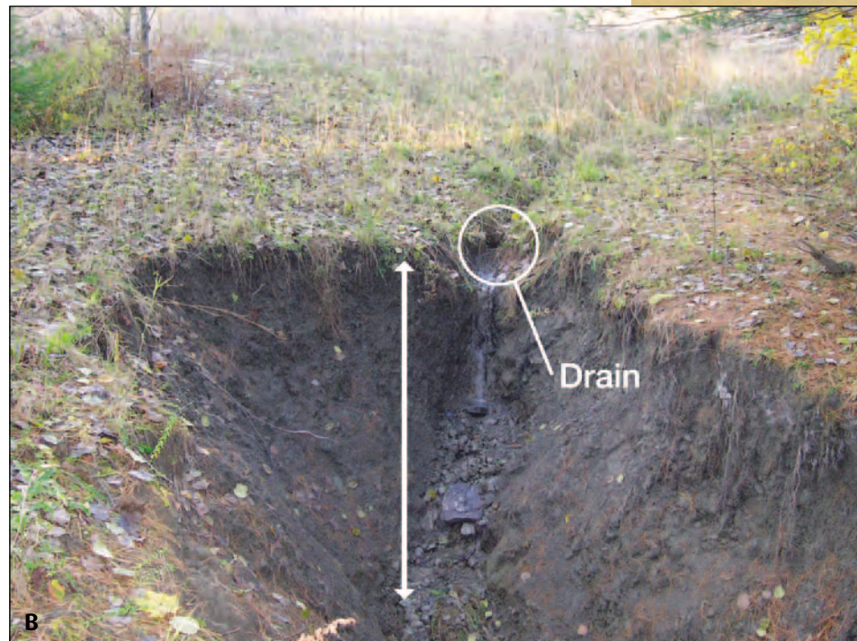
Figure 16 : Concentration d'eau (A : ravinement, B : érosion verticale)
