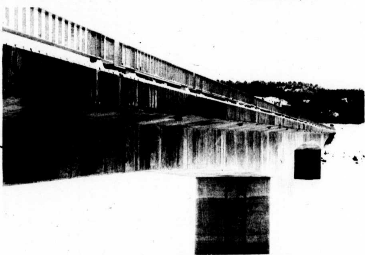
Voici une magnifique vue du nouveau pont Roméo Lorrain, d'une longueur de 520 pieds, qui fut construit au coût d'un million de dollars, par la firme W. D. Laflamme de Hull.
