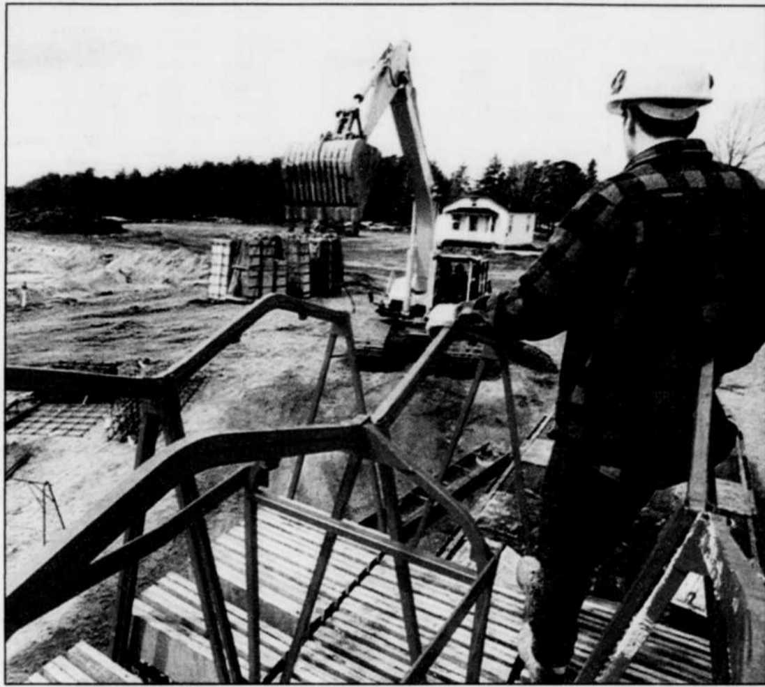
Un nouveau marché d'alimentation Provigo est en chantier, depuis quelques jours, rue Thibeau, à Cap-de-la-Madeleine. (Image-Média: Alain Bédard)
