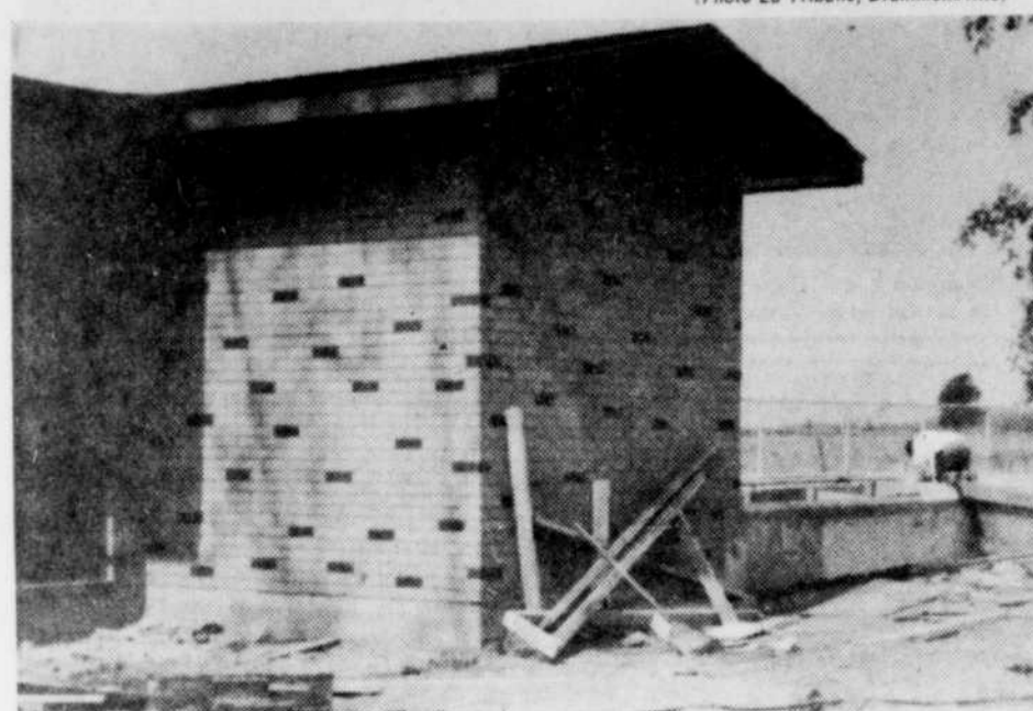
LA BATISSE — Voici l'aspect que prend l'usine d'épuration qui est en voie de parachèvement à St-Cyrille dans le comté de Drummond.
