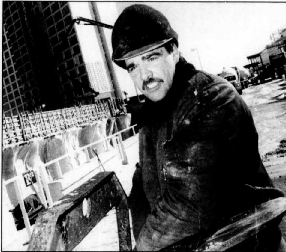
LES RÉPONDANTS À UN SONDAGE de CJRC-Ad Valorem sont d'accord avec les travaux d'agrandissement en cours au Casino de Hull. Selon eux, les impacts positifs du Casino compensent pour les effets négatifs, comme les faillites et les suicides. Sur la photo, Marc St-Laurent, travailleur de la construction. Photo : Serge Paquin
