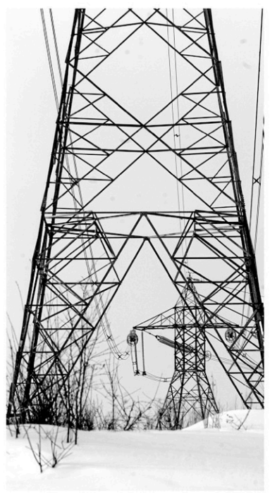
Le tracé de 309 kilomètres au total (dont environ 80 kilomètres au Québec) du Northern Pass devait relier le poste des Cantons, situé à Val-Joli, et le poste de Franklin, dans le sud du New Hampshire. — PHOTO LA TRIBUNE, ARCHIVES
