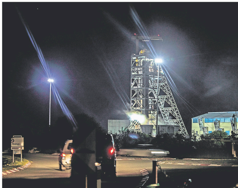
Une panne d'électricité, consécutive à un violent orage, a provoqué l'arrêt des ascenseurs et empêché dans la matinée la remontée de l'équipe de nuit de la mine de Beatrix, près de la ville de Welkom, en Afrique du Sud. Neuf cent cinquante-cinq mineurs, apparemment tous sains et saufs, étaient bloqués sous terre depuis 24 heures. — PHOTO AFP, GIANLUIGI GUERCIA
