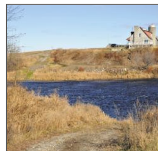
Accès au pont. Photo # 151117_5401 : Denis Béchard
