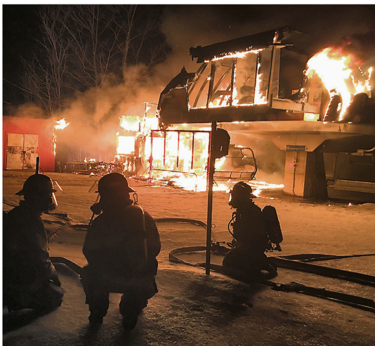
Un important brasier a détruit un édifice du Versant du Lac à Bromont, montagne d'expériences, et fortement endommagé la structure du remonte-pente. — PHOTO FOURNIE PAR LE SERVICE DE SÉCURITÉ INCENDIE DE BROMONT
