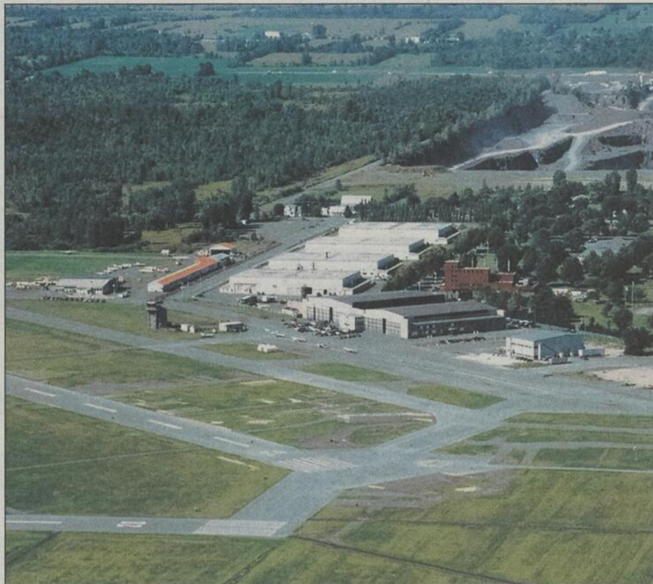
Le site temporaire de l'aéroport comporte plusieurs avantages, note la SNQ, comme l'espace pour le stationnement et le regroupement de toutes les activités, y compris le feu d'artifice.
