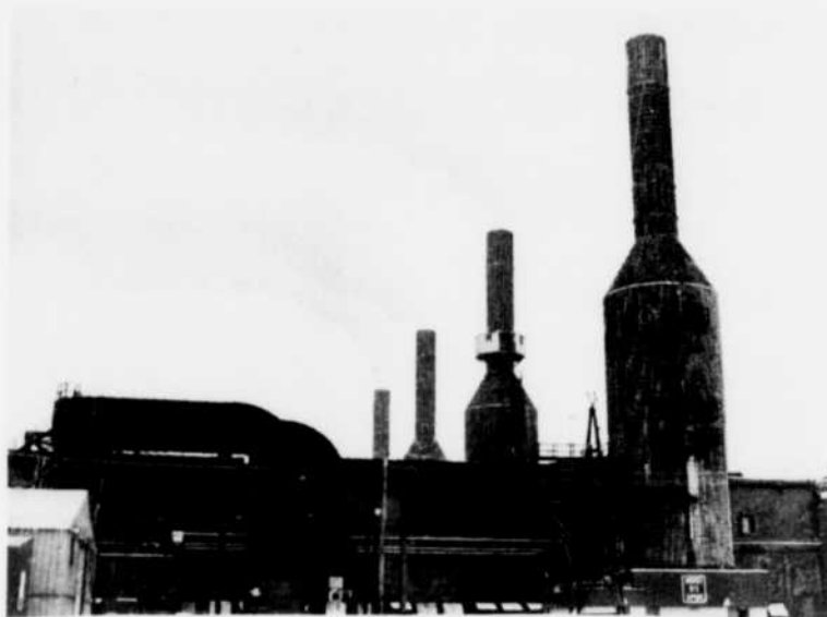
Vue de l'épurateur 57 Nord et de la salle de pompage.
