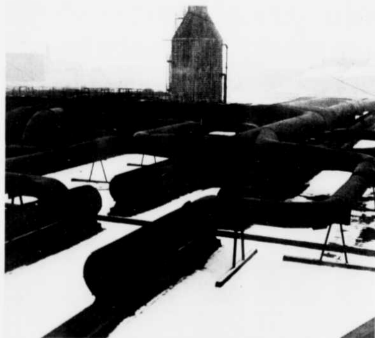
Une partie du circuit de ventilation, sur la toiture d'une salle de cuves. Au fond, un épurateur.
