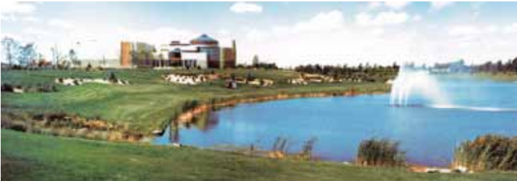
Centre d'épuration de la Rive-Sud, situé sur l'île Charron
