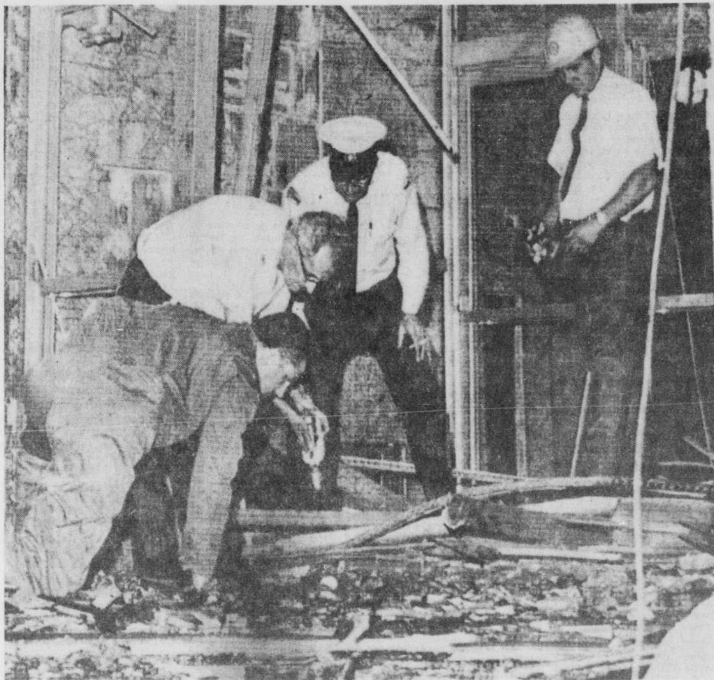
ÇA RECOMMENCE — Policiers et ouvriers s'affairent autour de la porte et des fenêtres fracassées de l'édifice du ministère de la Main-d'oeuvre et de l'Immigration, à Montréal, peu après l'explosion d'une bombe, ce matin.
