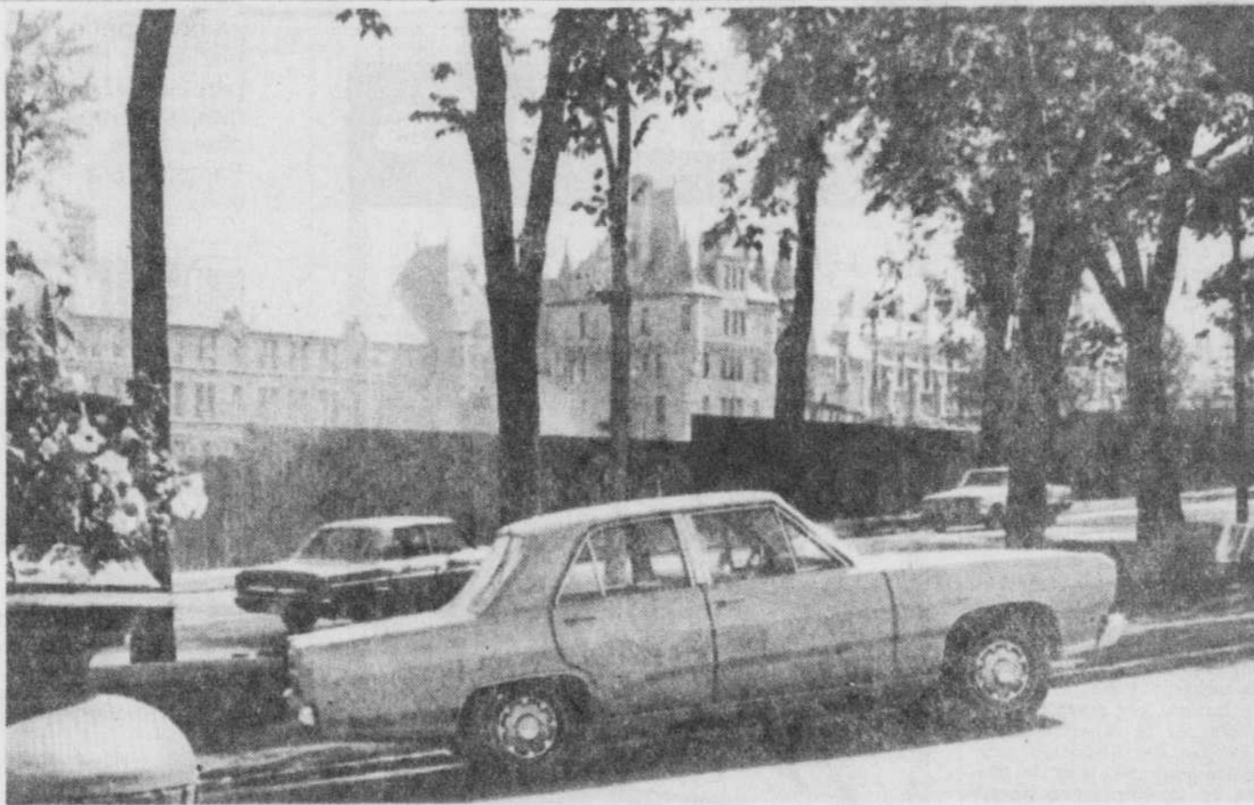
POUR QUELQUES MOIS SEULEMENT — Les citoyens de la Vieille Capitale ont découvert avec joie le coup d'oeil nouveau qui s'offre sur la Colline parlementaire à la suite de la démolition des maisons en bordure de la Grande-Allée. A travers les grands arbres, le Manège militaire et ses
