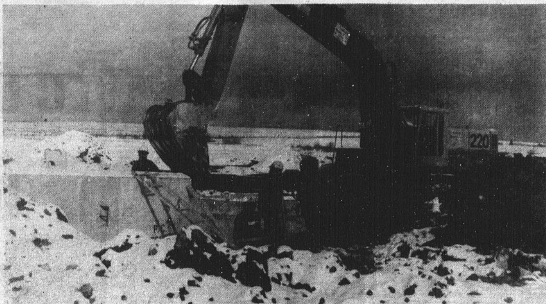
Des ouvriers complètent ici l'aménagement d'un étang d'oxydation.
