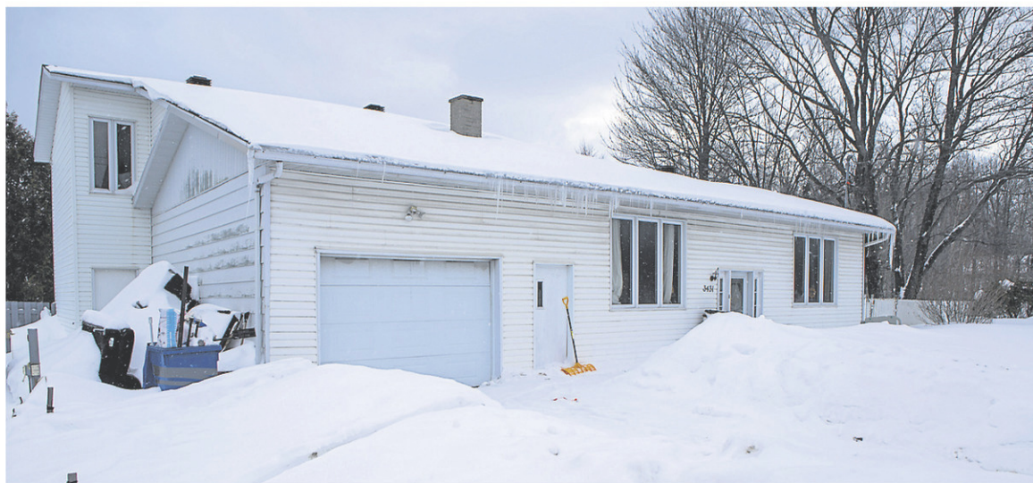
La résidence qu'occupaient Paméla, Carole et leurs six enfants a été peu endommagée, du moins, pas au niveau de sa structure. — PHOTO: OLIVIER CROTEAU
