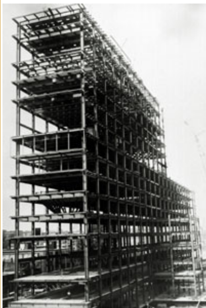
L'édifice Parthenais en construction vers 1965
