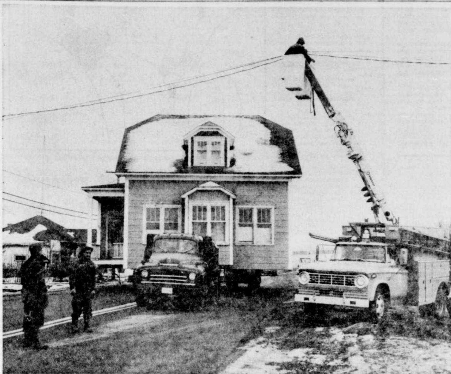
PARTIS DE LA RUE DOUCET, A TROIS-RIVIERES-OUEST, les employés de l'entreprise Pierre Bellemare, de Trois-Rivières, ont déménagé une maison jusqu'à la rue Duval, plusieurs mille pieds plus loin. Le déménagement de la maison a été rendu nécessaire à la suite
