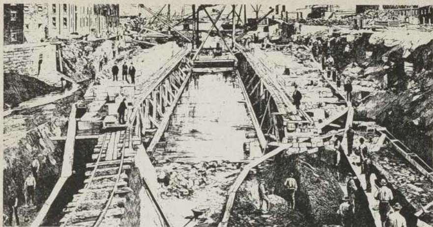
Travaux d'élargissement du canal-1877
