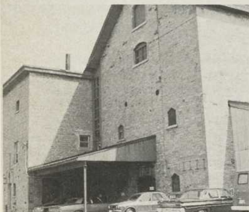
Maison des Vins Bright, 29 e avenue ▲
