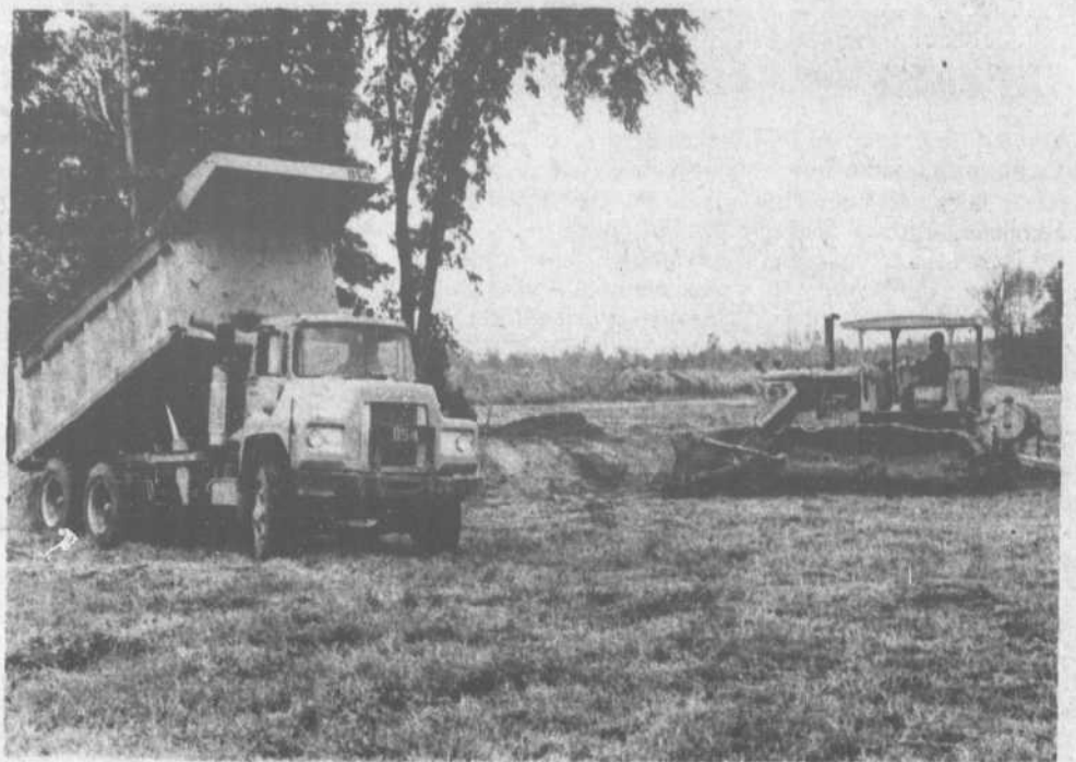
Nous avons capté cette photo, sur le côté nord-est de la voie ferrée du Pacifique Canadien, près de la route 640, dans le secteur industriel de Mascouche. La firme Lacombe Planning Mills a fait l'acquisition de vastes étendues de terrain où elle projette d'installer ses locaux, en 1975. Plusieurs de ces imposants camions transportant présentement des tonnes de sable afin de hausser le niveau du terrain où certaines des installations seront établies; une route privée et une piste d'atterrissage font partie du programme des travaux qui doivent être effectués sur cette terre.
