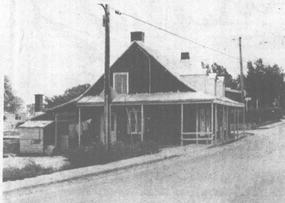
Cette maison oblige les écoliers qui fréquentent l'école La Mennais à marcher dans la rue pour pénétrer dans la cour de l'école. On parle depuis longtemps d'exproprier cette bâtisse mais il semble que les procédures soient fort longues. Il est à souhaiter que celles-ci soient complétées avant que le nouveau parc La Mennais puisse être utilisé.
