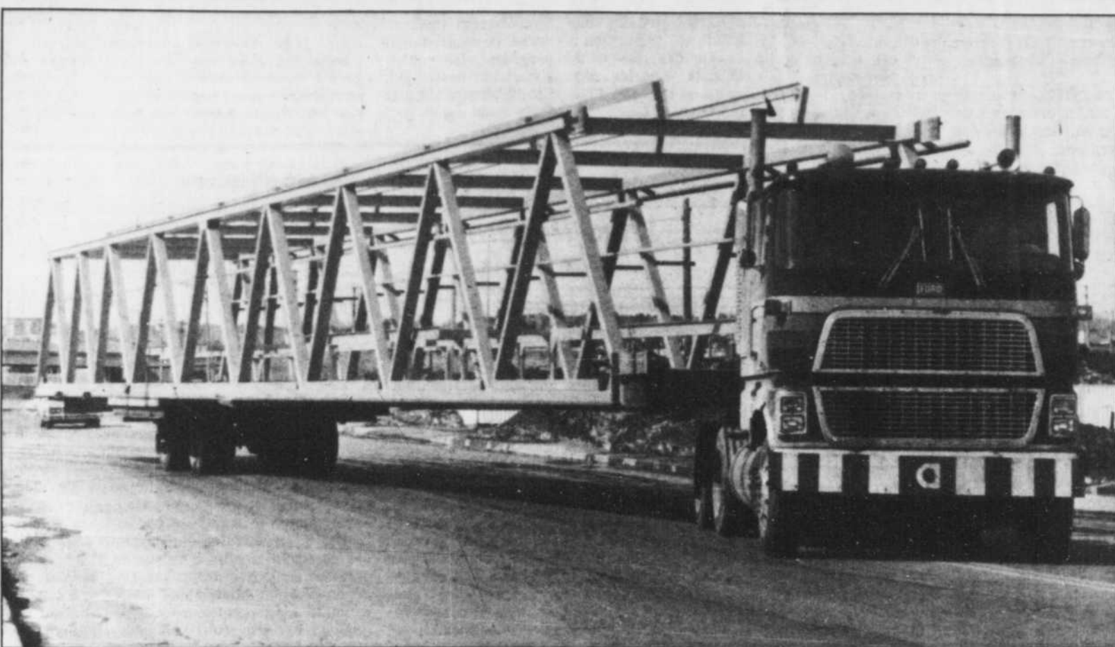
Pour assurer la livraison du produit fini à Bécancour, la compagnie Structure CQS a fabriqué un long fardier en son usine. La longueur des sections varie de 100 à 150 pieds et de 20 à 25 tonnes par unité. (Flageol Photo — Terry Charland)
