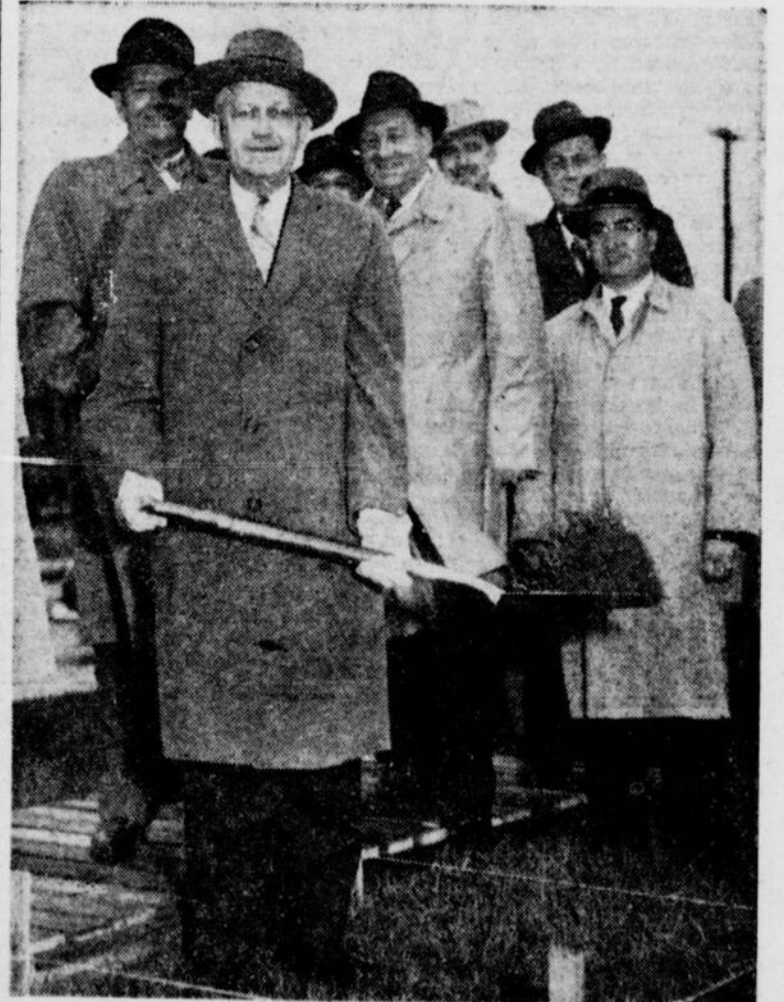
PREMIER COUP DE BECHE — M. S. Beringer, président de la British-American Oil Company, a levé la première pelletée de terre du nouvel édifice administratif de la région de l'est de la compagnie, édifice qui sera érigé à Ville Mont-Royal. M. Beringer est entouré ci-dessus d'autres officiers supérieurs de la compagnie.
