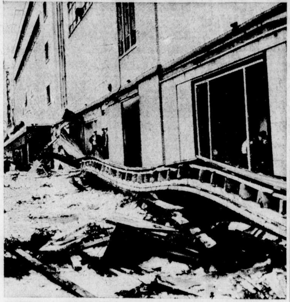
TRAGÉDIE INUSITÉE À QUÉBEC — A une heure d'affluence, dans une rue fort achalandée de Québec, une douzaine de passants ont été emprisonnés hier sous la masse d'une marquise qui s'est effondrée sur une longueur de 150 pieds. 2 piétons ont été broyés sous les débris de la marquise et 10 autres personnes ont été blessées. La tragédie est survenue devant le magasin Pollack, boulevard Charest.
