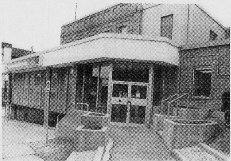
RENOVATION - La banque de Montréal a changé son guichet automatique de place. On peut y accéder par la rue Labrègue.
