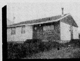
217 des Tilleuls, Sacré-Coeur, Rimouski. Bungalow, sous-sol aménagé. Foyer.
