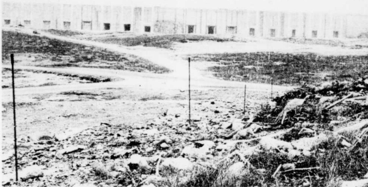
Les 16 prises d'eau pour les turbines qui disparaîtront lors de la mise en eau du réservoir.
