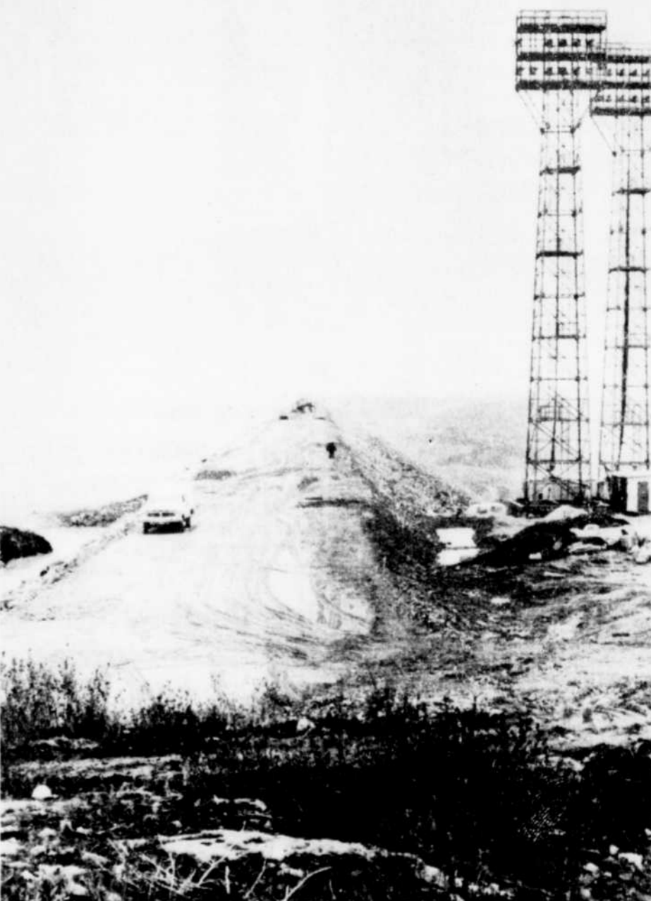
Il ne reste que de légers travaux à effectuer au sommet du barrage principal avant qu'on puisse dire qu'il est entièrement achevé.
