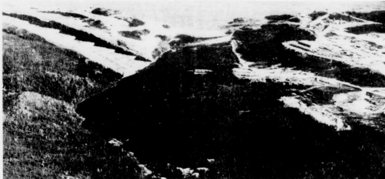
D'ici quelques semaines, la rivière La Grande sera complètement détournée de son lit millénaire. Les travaux d'endiguement sont complétés et nous apercevons sur cette photo le bar-
