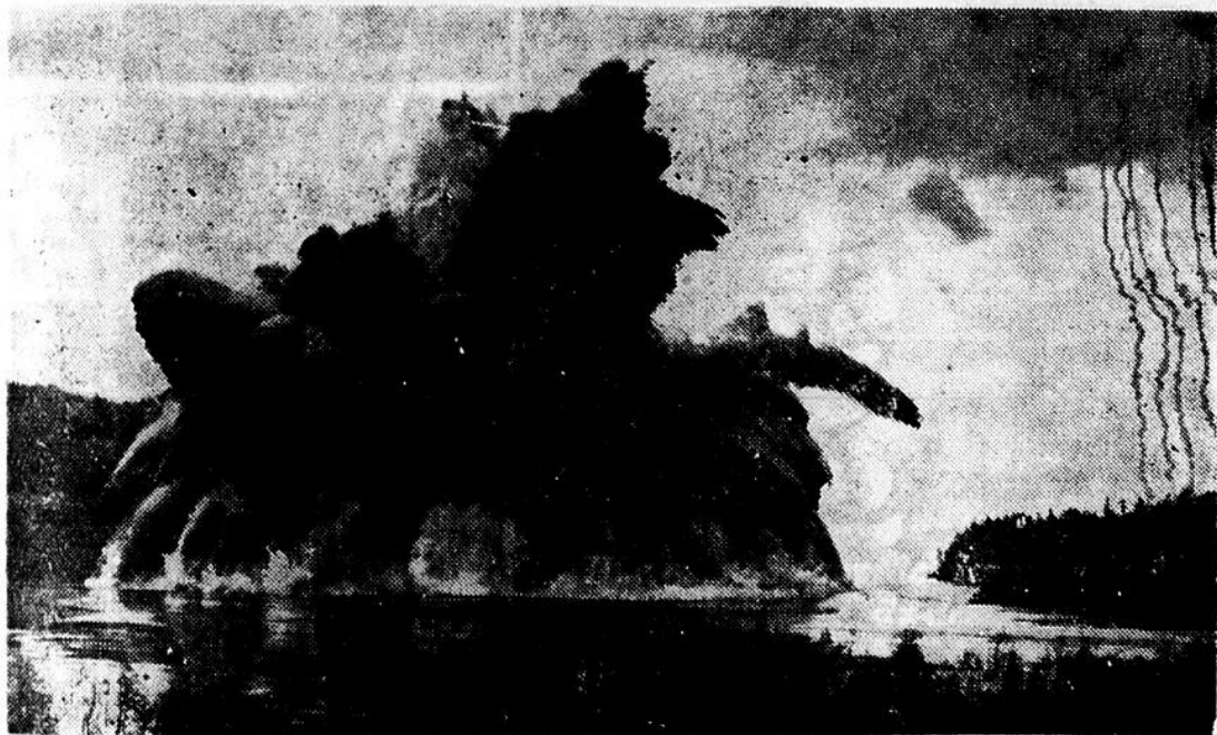
Les deux pics de Ripple Rock explosent en projetant dans les airs des débris de roc et une énorme masse d'eau; cette scène constitue la plus grande explosion (sauf les explosions atomiques) de l'histoire. Ce rocher, entre Campbell River, en Colombie-Britannique, et l'île de Vancouver, a causé la mort de 114 marins, depuis 1875. L'explosion de 1,375 tonnes de dynamite couronnait un travail de trois ans qui avait coûté quatre millions de dollars. On avait percé un tunnel de 2,000 pieds, à partir de l'île de Mod,
